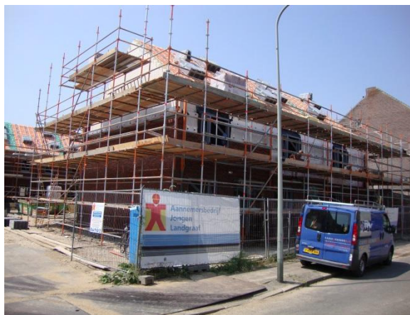
Demerthofje, tweede fase, in aanbouw (oplevering 2015)
